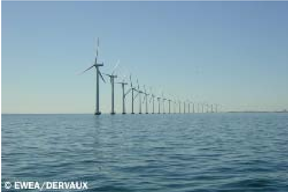
Princes Amalia-Q7, 60 Turbinas de 2 MW situada a 23 km de la costa en una profundidad de 19 a 24 m, Holanda (2008)
