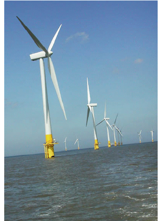
Thanet Offshore Wind Farm 300 MW cuenta con 100 turbinas de 115 m, al sureste de Inglaterra (2010)
