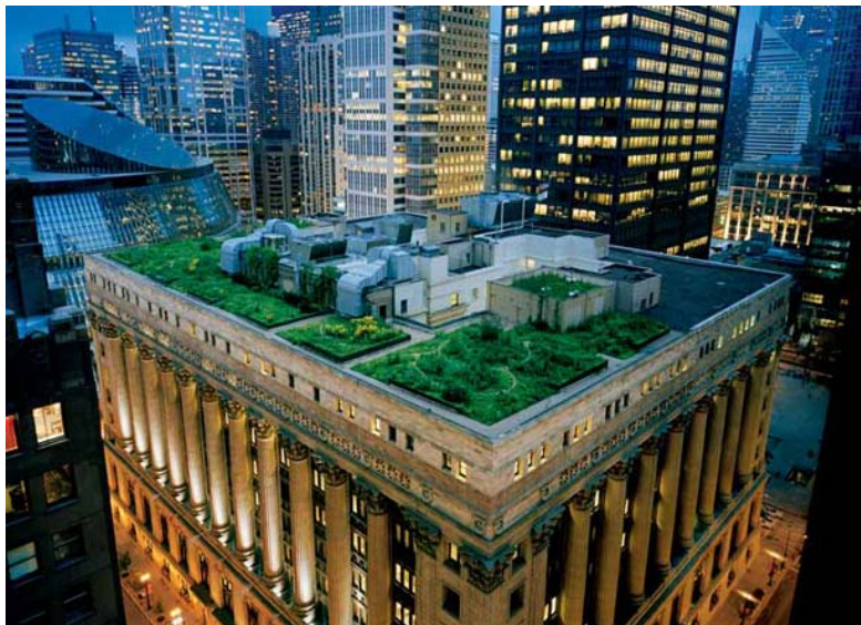
Fig. 5. Techo verde. Empleo de la vegetación para otorgar diversos beneficios a las ciudades y sus habitantes.
